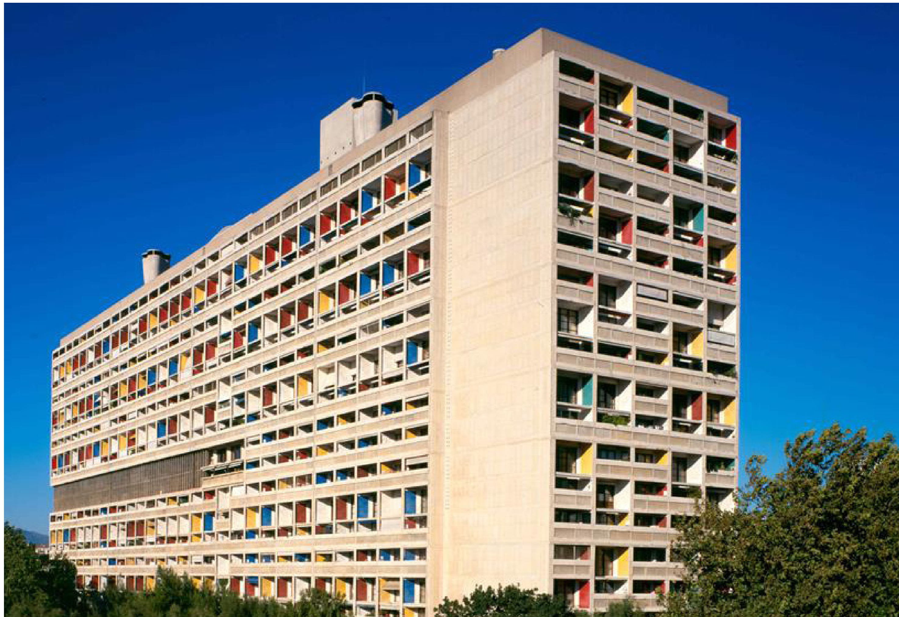
Unité d'Habitation Marseille, France 1945
